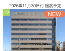
22 熊本イーストフロントビル
