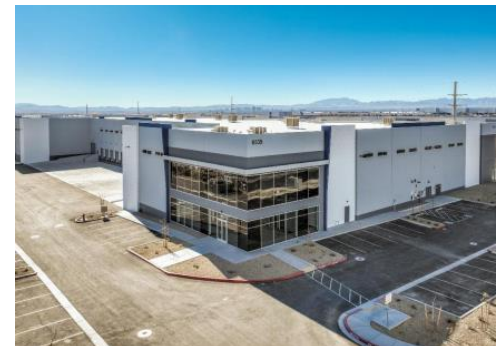
ラスベガス物流倉庫 (米国ネバダ州)
