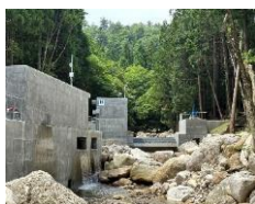
小水力発電 （滋賀県高島市・FIT）
