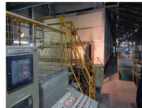
北勢工場の耐火被覆材製造ライン
