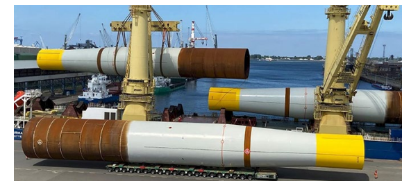
ドイツ北東部ロストックの積み出し港で運搬船に積載されるモノパイル
