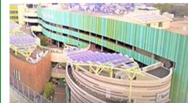
太陽光発電システム
