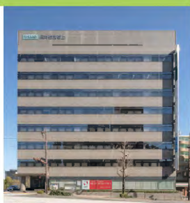
熊本イーストフロントビル
