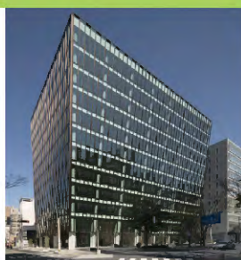
博多FDビジネスセンター
