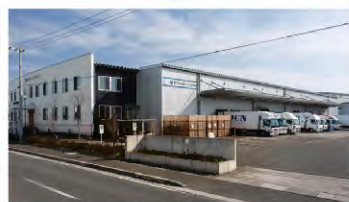
鳥栖ロジスティクスセンター
