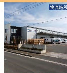
鳥栖ロジスティクスセンター
