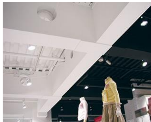
はりの耐火被覆（商業施設）
