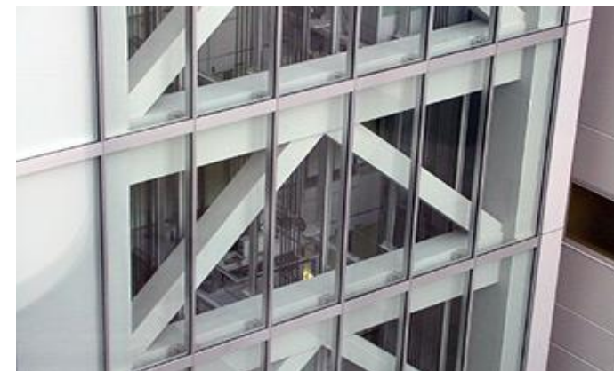
EVシャフト・ブレースの耐火被覆（複合ビル）
