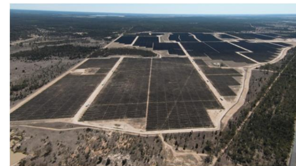
完成写真（2023年9月）
