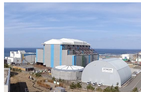
建設中の大間原子力発電所 (青森県)
