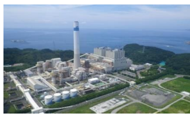
現在の松島火力発電所（長崎県）
