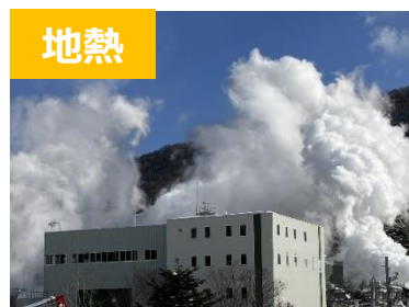
鬼首地熱発電所 (宮城県)
