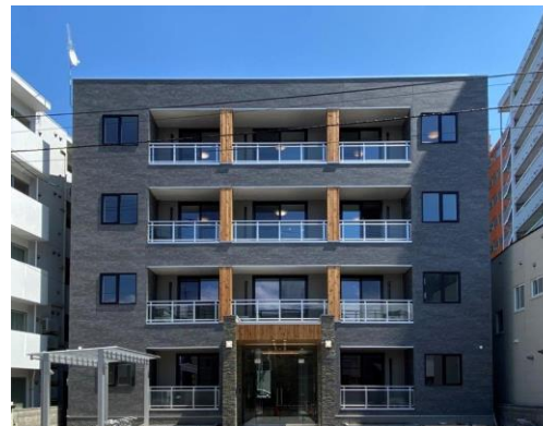
SE構法木造ビル
