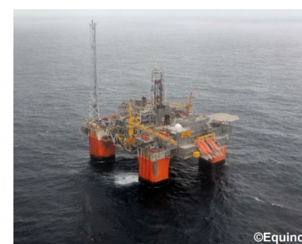
スノーレプロジェクト 生産施設
