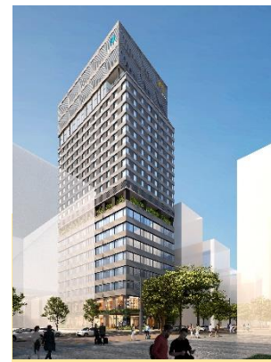
ヒューリック福岡ビル建替計画 (建替)
