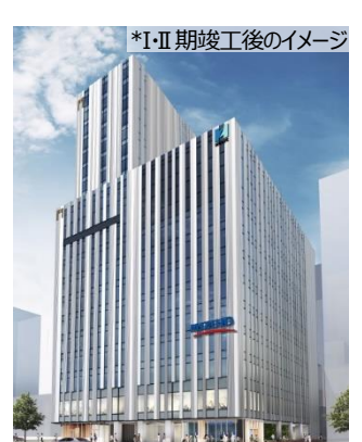
ヒューリックスクエア札幌(Ⅱ期棟) *解体着工(建替)
