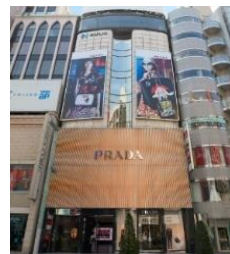
ヒューリック銀座 ワールドタウンビル
