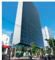
ヒューリック神宮前 タワービルディング
