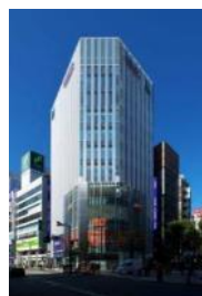
ヒューリック 新宿ビル
