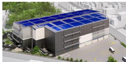
ヒューリックロジスティクス野田Ⅰ（非FIT）
