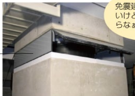
免震装置用耐火被覆材
