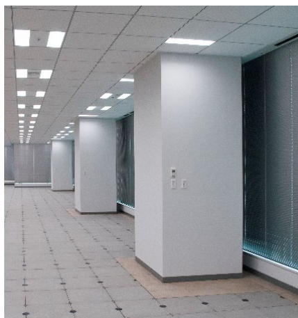
柱の耐火被覆（オフィス）
