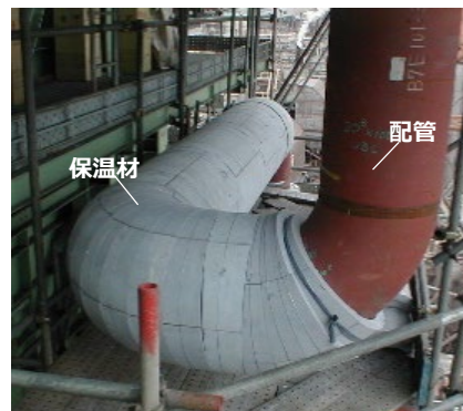
保温材取付け (施工中)
