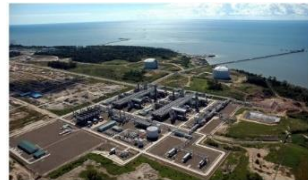
タンクーLNG基地(インドネシア)
