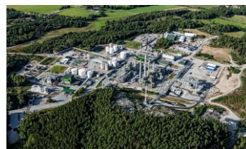
製造工場全景
