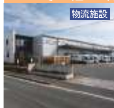
鳥栖ロジスティクスセンター
