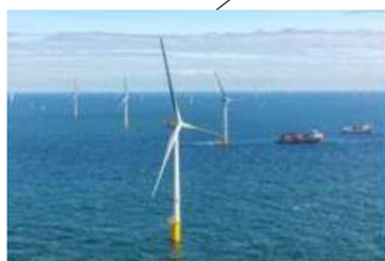
ボルセレ III/Ⅳ 洋上風力発電所
