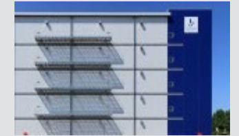
断熱性・水密性に優れた サンドイッチパネルの外壁
