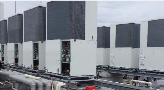
新型空調設備への改修
