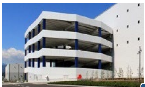
大型ランプウェイ等 上層階にトラックが直接アクセス 可能な大型ランプウェイ又は充分 な搬送能力を備えた垂直搬送機能
