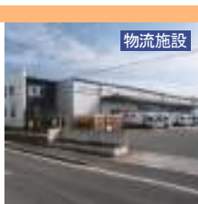
鳥栖ロジスティクスセンター
