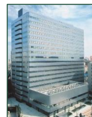
横浜STビル (神奈川県横浜市)
