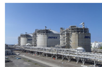
Naoetsu LNG Terminal (Niigata, Japan)
