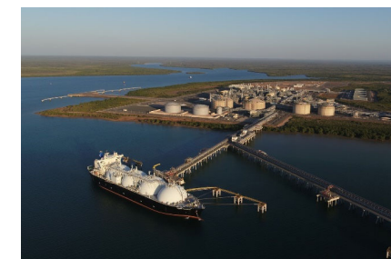
Onshore LNG Plant (Darwin, Australia)
