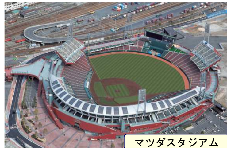
商業施設の電気設備
