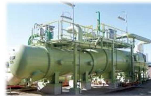
■ LNG気化器 (中間熱媒体式：OG-TRI-EX)
