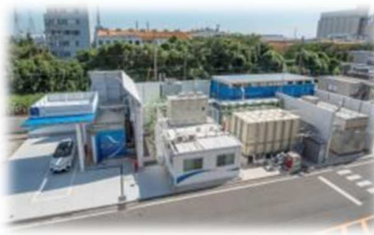
■ MKK川崎水素ステーション
