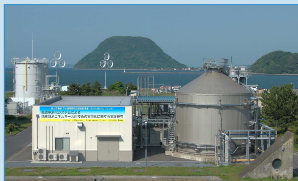
下水バイオガス原料による水素等創エネ技術 (国交省B-DASHプロジェクト唐津市実証設備)
