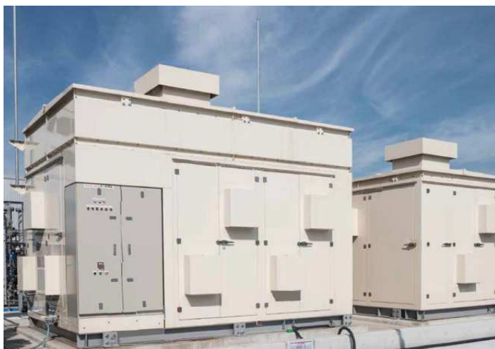
SPERA水素型水素ステーション用 脱水素パッケージ(小型実証機の外観写真) 提供:千代田化工建設
