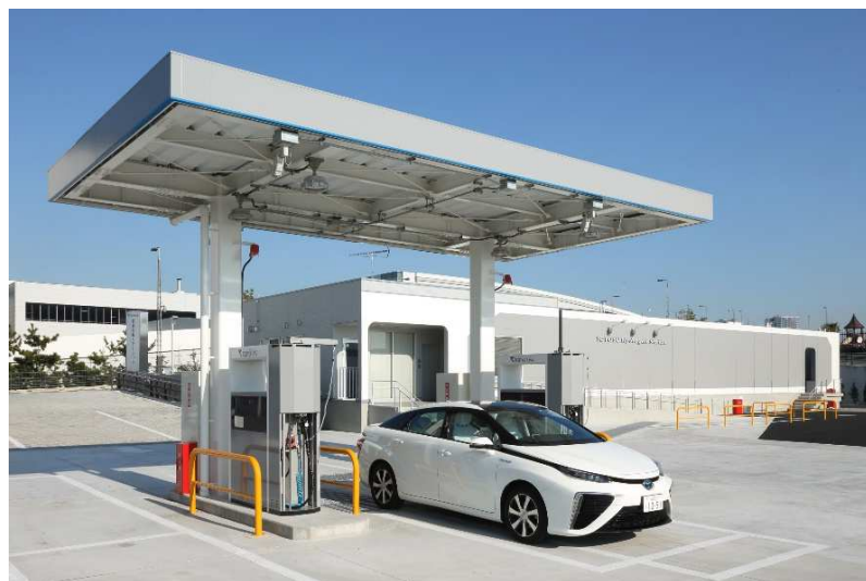
豊洲水素ステーション
