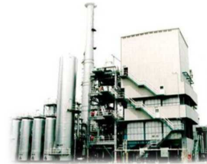
■ LNG気化器 (中間熱媒体式：OG-TRI-EX)
