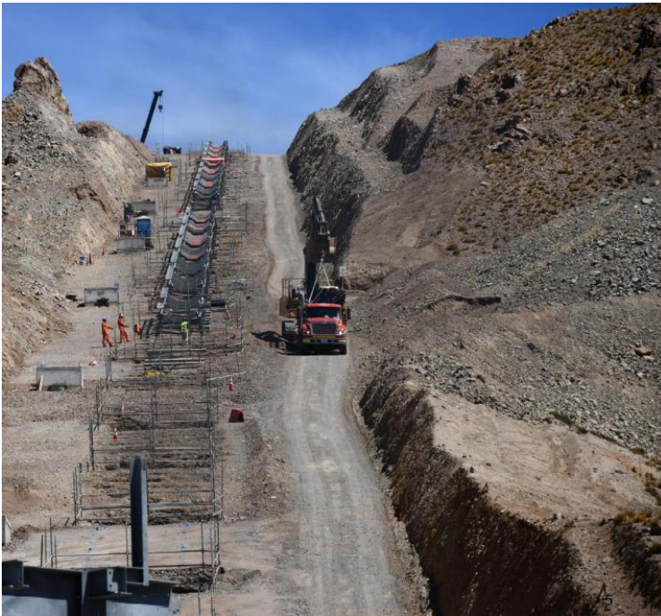
コンベヤ設置
