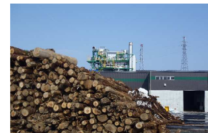
バイオマス発電所 (山形県米沢市)
