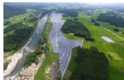
太陽光発電所 (栃木県日光市)
