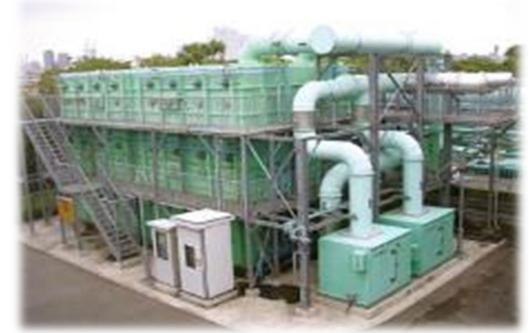
■ 超高速沈殿装置
