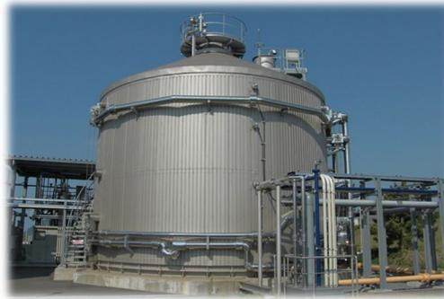
■ 生物脱臭プロセス（充填式生物脱臭法）
