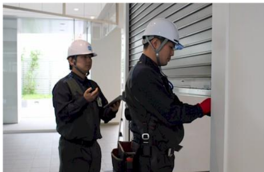
防火シャッター法定点検イメージ
