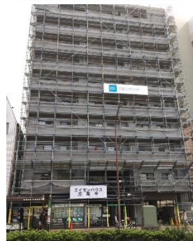
リニューアル工事中のビル
