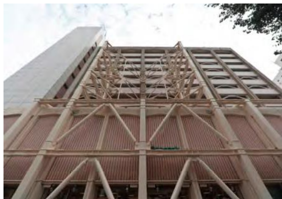
マンション耐震補強工事の施工事例
