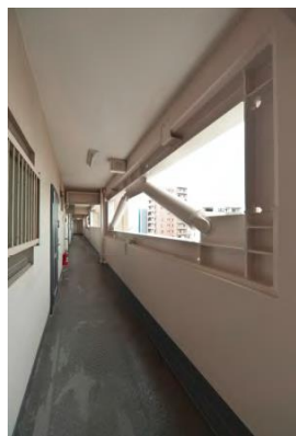
マンション耐震補強工事の施工事例
