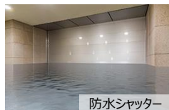
防水シャッター
