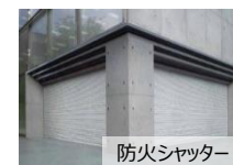
防火シャッター
