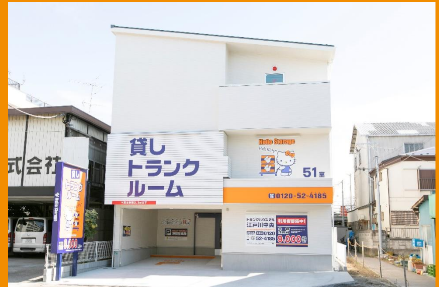
トラックハウス24江戸川中央 51室
