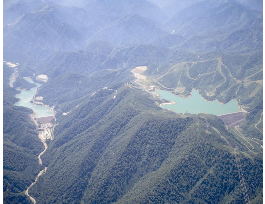
おくきよつ 右：奥清津（揚水、100万kW、新潟県）
