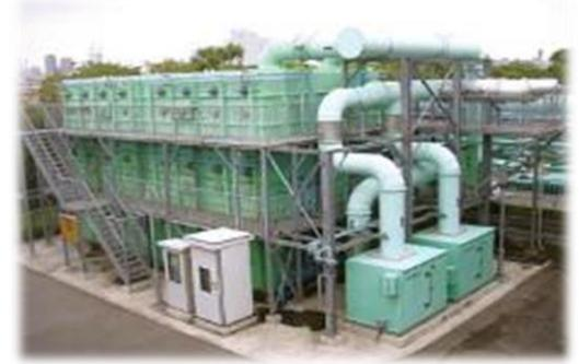
■ 超高速沈殿装置
