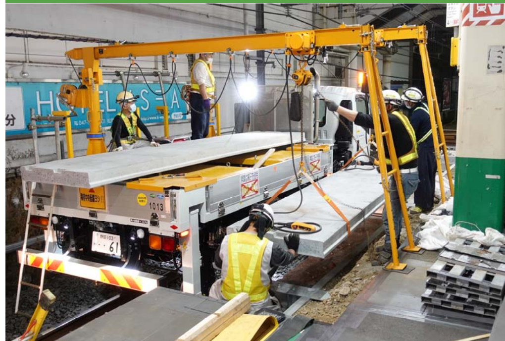
軌陸式門型クレーン
