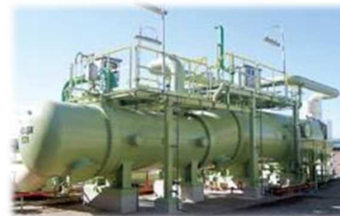
■ LNG気化器 (中間熱媒体式：OG-TRI-EX)
