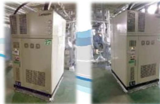
■ 消化槽の熱回収（ヒートポンプ）
