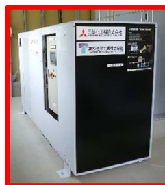
水電解水素製造装置
