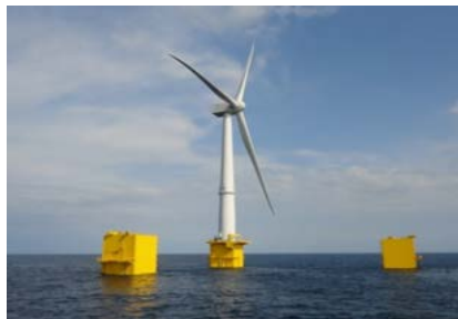
福島浮体式洋上風力実証研究
