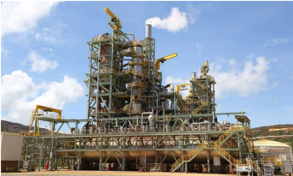
HPALプラント(フィリピン)
