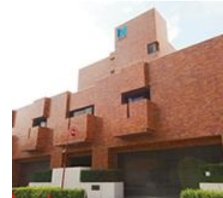
千駄ヶ谷センタービル
