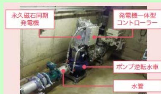
(管水路用マイクロ水力発電システム)
