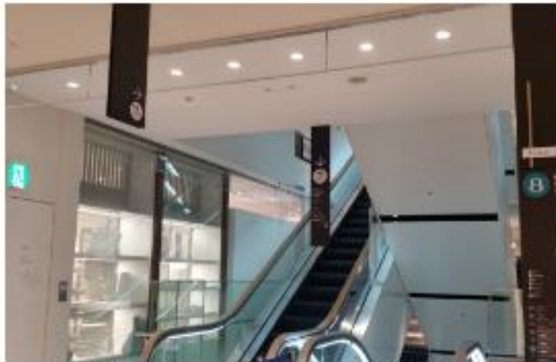
改装とあわせて天井照明をLED化 (大丸東京店)
