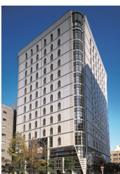
B-22 堺筋本町ビル
