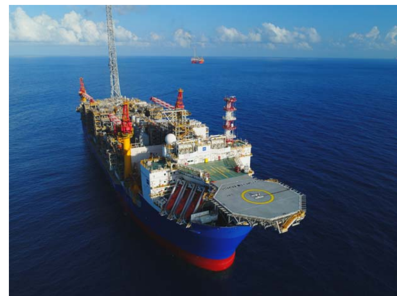
イクシス ガス・コンデンセート田のFPSO
