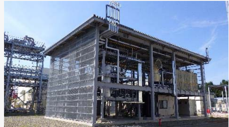
メタネーション試験設備
