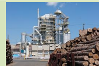
木質バイオマス(12MW)
