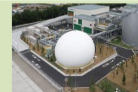
バイオガス(1.8MW)
