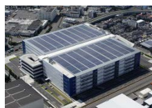
評価Sランク ★★★★★ ロジポート橋本
