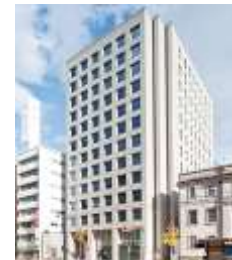
【Hiroshima Fukuromachi Bldg.】
