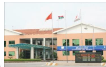
タンロン工業団地 第二タンロン工業団地 （計173社）
