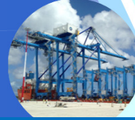
港湾荷役クレーン
