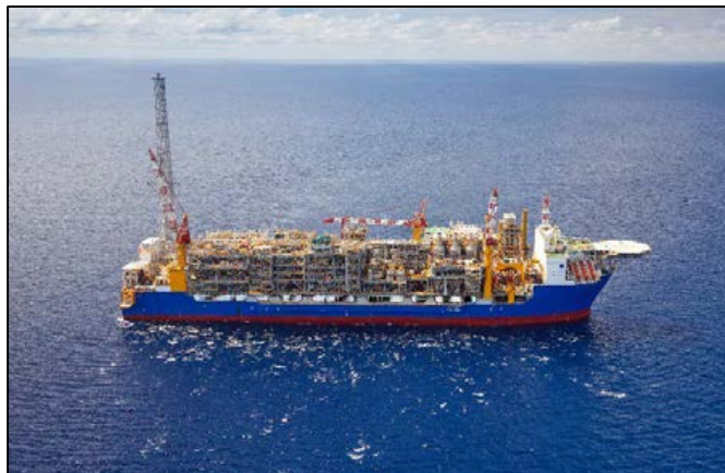
FPSO「イクシス ベンチャラー」
