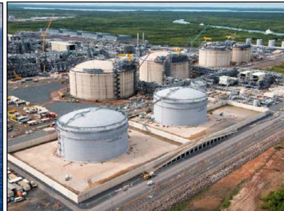
陸上施設タンクエリア
