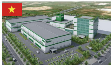
ベトナム新工場 （ホアラク・ハイテクパークに建設中）
