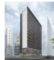
ヒューリック銀座花菱通ビル
