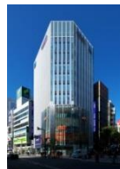
ヒューリック新宿ビル
