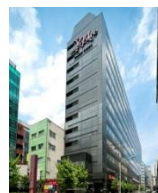
ヒューリック銀座二丁目ビル
