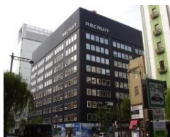
ヒューリック銀座7丁目ビル 旧昭栄合併（全50物件）
