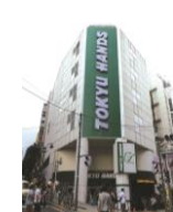
ヒューリック渋谷宇田川町ビル
