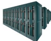
データセンター
