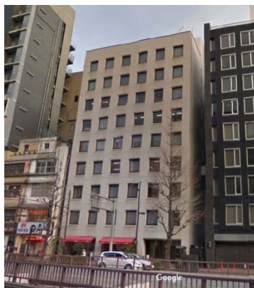
ヒューリック銀座イーストビル
